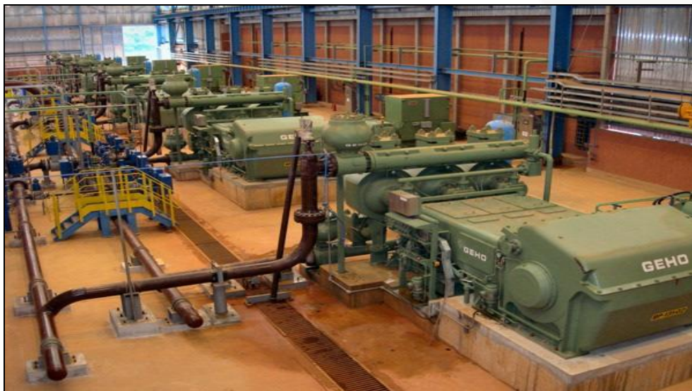
Figura 67. Bomba de desplazamiento positivo
