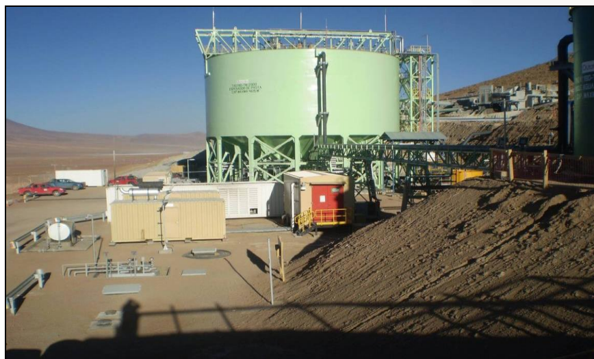
Figura 65. Espesador de pasta.
