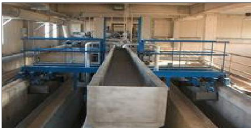
Figura 163. Desarenador longitudinal.
