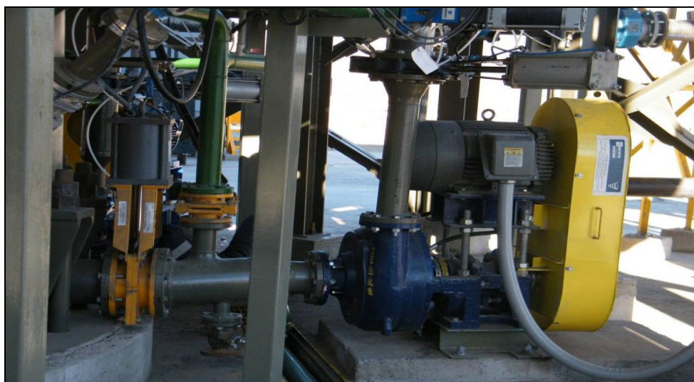
Figura 68 Bomba centrífuga
