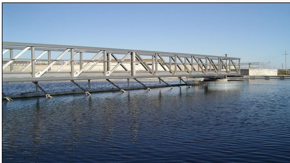
Figura 173 Puente de un espesador
