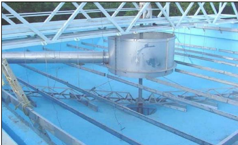
Figura 164. Clarificador circular.
