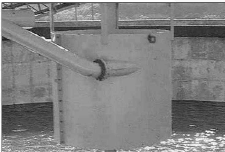
Figura 168 Feedwell con dos tubos tangenciales de alimentación
