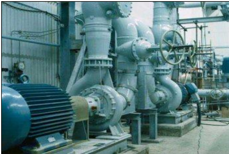
Figura 151 Bombas centrífugas de carga
