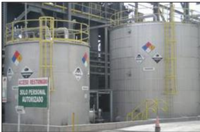
Figura 80 Estanques de almacenamiento de NaSH.
