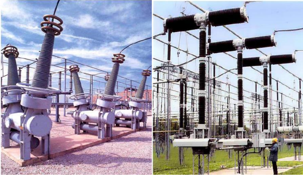
Figura 24 Interruptores tipo tanque muerto y tanque vivo.
