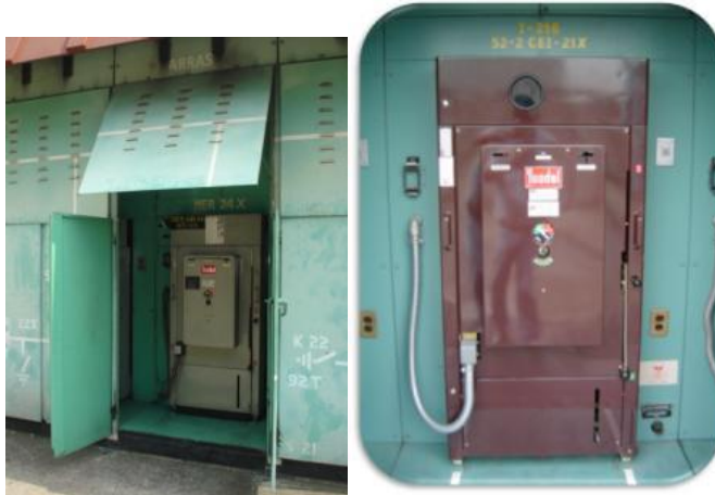
Figura 23 Interruptores tipo interior Metal Clad en pequeño volumen de aceite.
