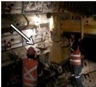
Retiro de revestimiento con lainera
