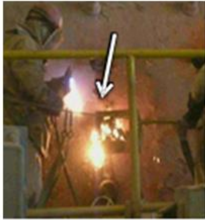
Corte de tuercas con equipo oxicorte
