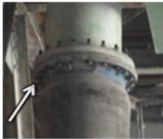
Cortar pernos (si se requiere)
