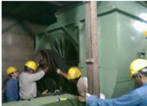
Cambio de bandas de un ventilador centrífugo
